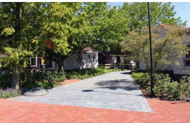
De rode gebakken klinkers zijn gebruikt daar waar veel beweging is. Grijze tegels in de rustigere woonstraten.
